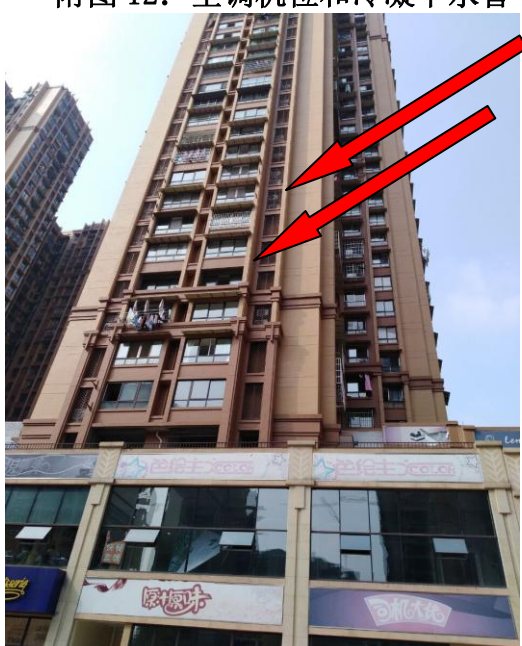
附图 12：空调机位和冷凝下水管
