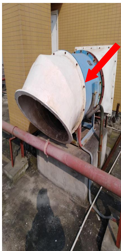
附图 7：发电机尾气排放口
