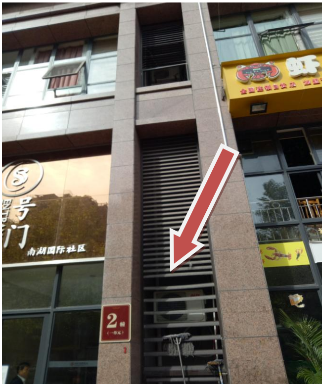
附图 10：空调机位与冷凝下水管
