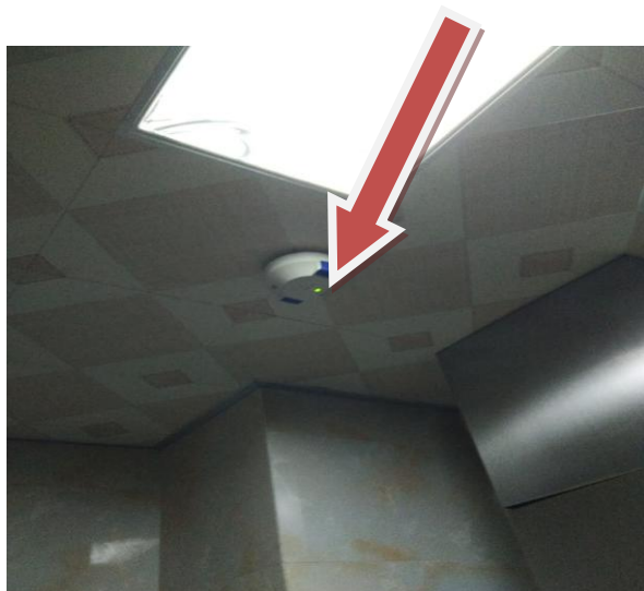
附图 11：天然气泄漏自动报警器、火灾自动报警器
