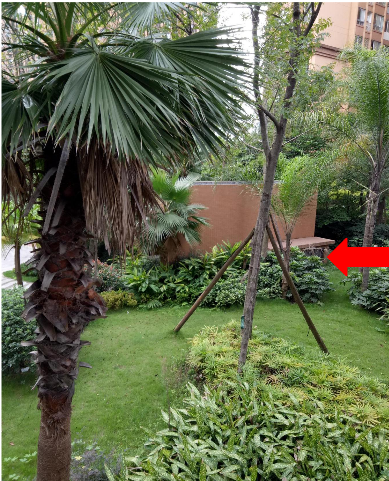
附图 8：地下车库换风出口
