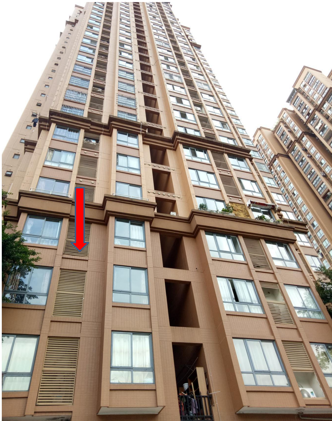
附图 15：住宅楼统一空调机位及冷凝水下水管
